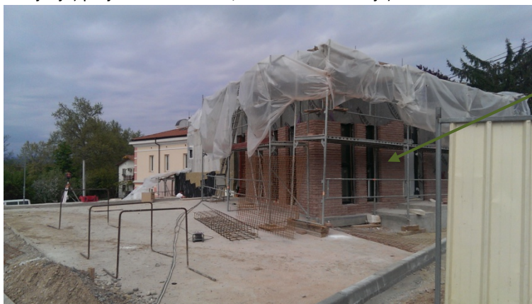
Slika 3: Obstoječe stanje na območju investicijskega projekta – prikaz del v teku v okviru 4. etape (3. etapa po gradbenem dovoljenju) projekta KUC II. Faza, ki se trenutno izvaja).
